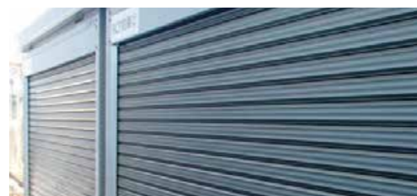
本社に設置された非常用備蓄品倉庫
