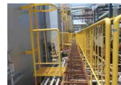
歩廊に安全策を設置し、新設工事における標準化としました。
